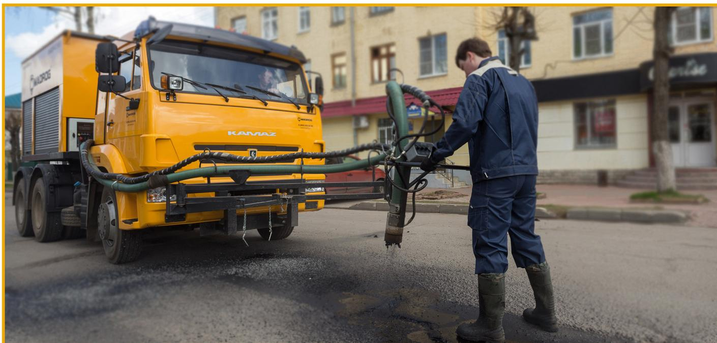
Nuestro sistema de calefacción de emulsión reduce al mínimo los costes de calefacción. Por lo que sabemos, ningún otro fabricante ofrece este sistema. El MADPATCHER necesita una tripulación de dos personas solamente (conductor y operador).
